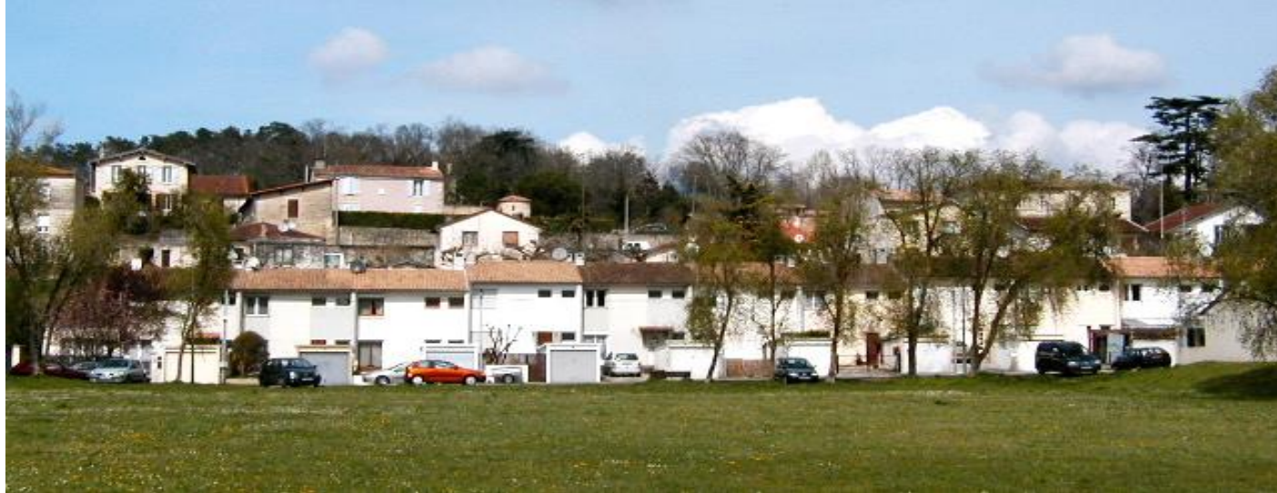
Immeubles en bande, lotissement de la « Croix Marron »
