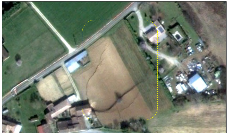
Fig. 78 : Effondrement du 08 février 2011 à SAINT-GERMAIN-DU-PUCH (Gironde) [Source : GoogleEarth]
