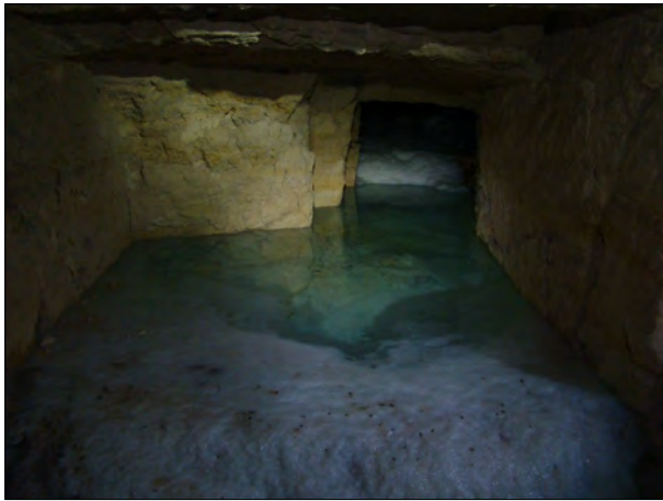
Fig. 42 : Nappe souterraine affleurante (à gauche) et karstification (à droite) dans la carrière de Brun (Niveau -3) [Source : Ginger CEBTP]
