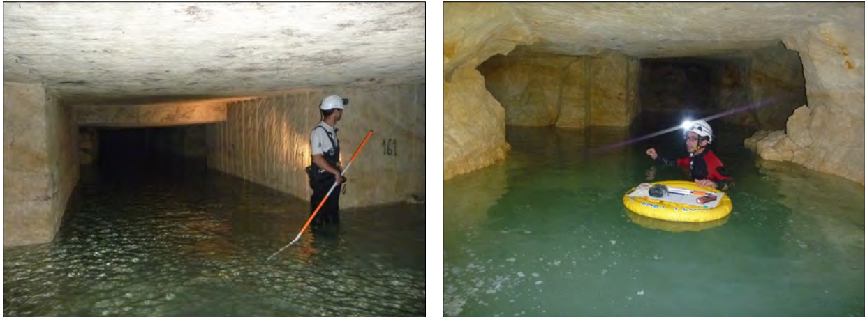
Fig. 44 : Carrières inondées : Château de LATRESNE (à gauche) et Gassies (à droite) [Source : Bureau des Carrières de Gironde]
