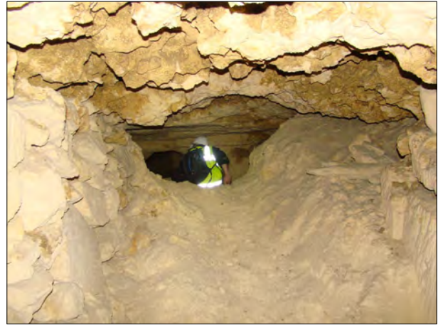
Fig. 42 : Nappe souterraine affleurante (à gauche) et karstification (à droite) dans la carrière de Brun (Niveau -3) [Source : Ginger CEBTP]
