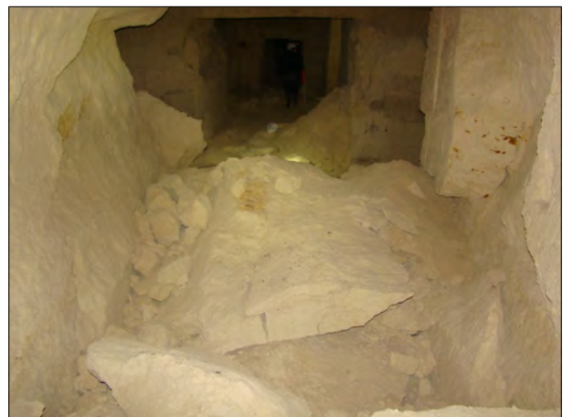
Fig. 43 : Fissuration du ciel (en haut, à gauche), éclatement d'un pilier malgré la présence de remblai (en haut, à droite), secteurs ruinés (en bas) dans la carrière de Brun (Niveau -3) [Source : Ginger CEBTP]
