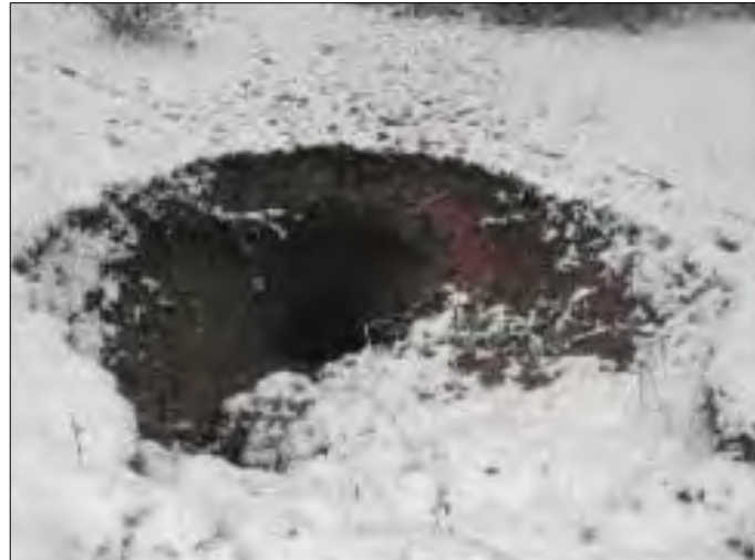
Fig. 15 : Effondrement d'une zone sous-cavée par suffosion [Source : BRGM]
