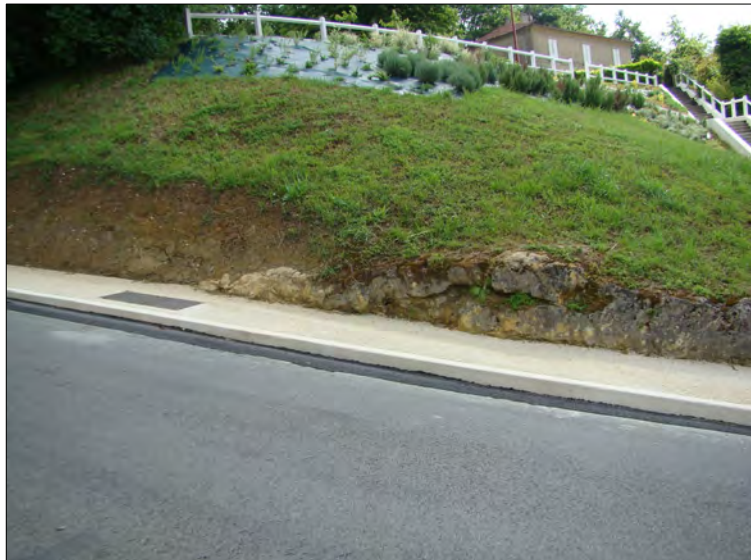
Fig. 5 : Contact entre formations fluviales anciennes et calcaires à Astérie, le long de la rue de la Chapelle [Source : Ginger CEBTP]
