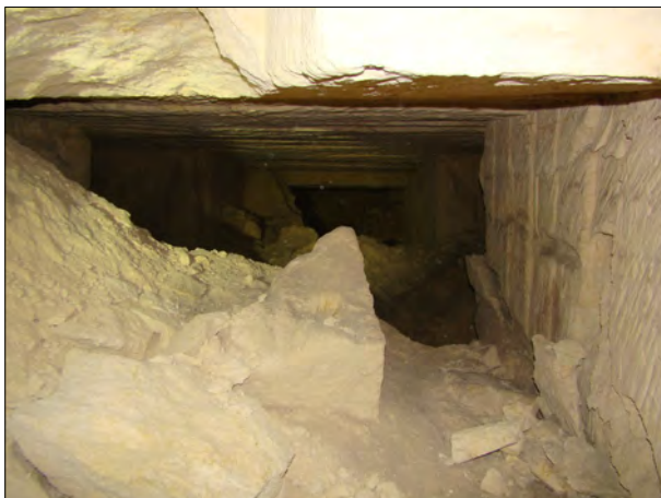
Fig. 43 : Fissuration du ciel (en haut, à gauche), éclatement d'un pilier malgré la présence de remblai (en haut, à droite), secteurs ruinés (en bas) dans la carrière de Brun (Niveau -3) [Source : Ginger CEBTP]
