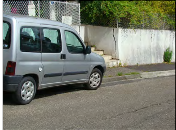
Fig. 49 : Fissuration de murs de soutènement impasse Saint-Joseph (à gauche) et chemin de la Fontaine (à droite) [Source : Ginger CEBTP]
