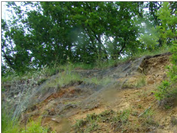
Fig. 50 : Grillage plaqué (en mauvais état), le long de la rue du Bourg (à gauche) et rideau de palplanches, le long de la Pimpine, chemin de Maucoulet (à droite) [Source : Ginger CEBTP]
