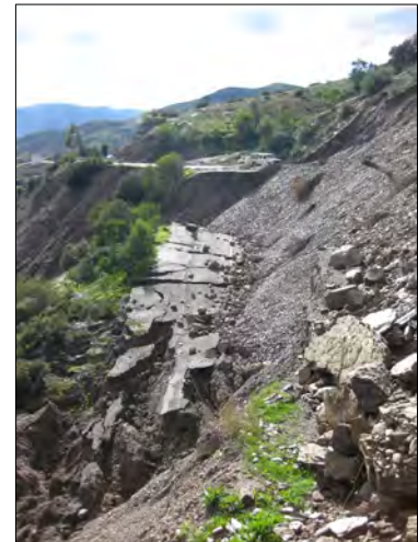
Fig. 18 : Schéma conceptuel d'un glissement de terrain et glissement en bordure de l'Oued Nekor (Maroc) [Source : Ginger CEBTP]
