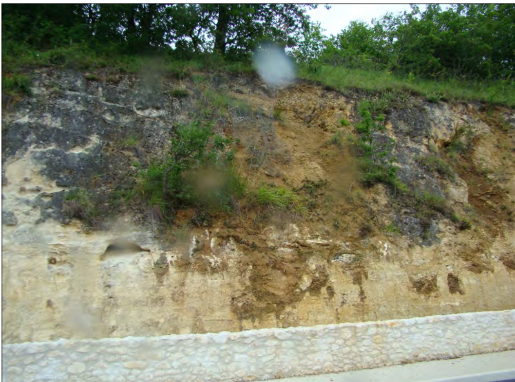
Fig. 46 : Escarpement calcaire, le long de la rue du Bourg, présentant des discontinuités (stratification, karst, fissuration, ...). A noter la mise en place d'un piège à bloc en pied [Source : Ginger CEBTP]
