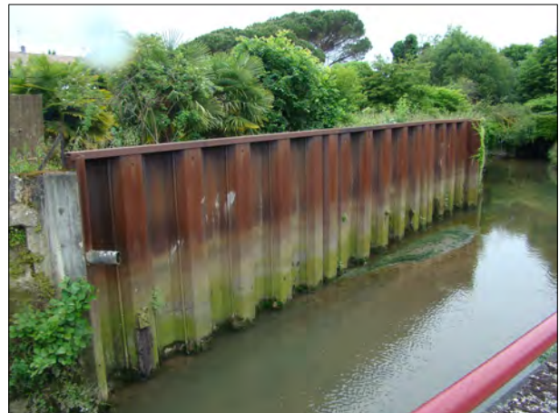
Fig. 50 : Grillage plaqué (en mauvais état), le long de la rue du Bourg (à gauche) et rideau de palplanches, le long de la Pimpine, chemin de Maucoulet (à droite) [Source : Ginger CEBTP]
